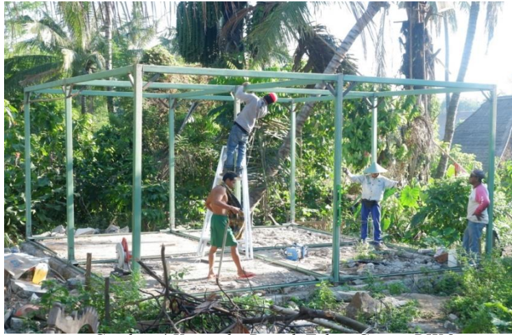
Gambar 4 Kerangka Rumah Tahan Gempa RIKO Sumber: Peneliti, 2019.
