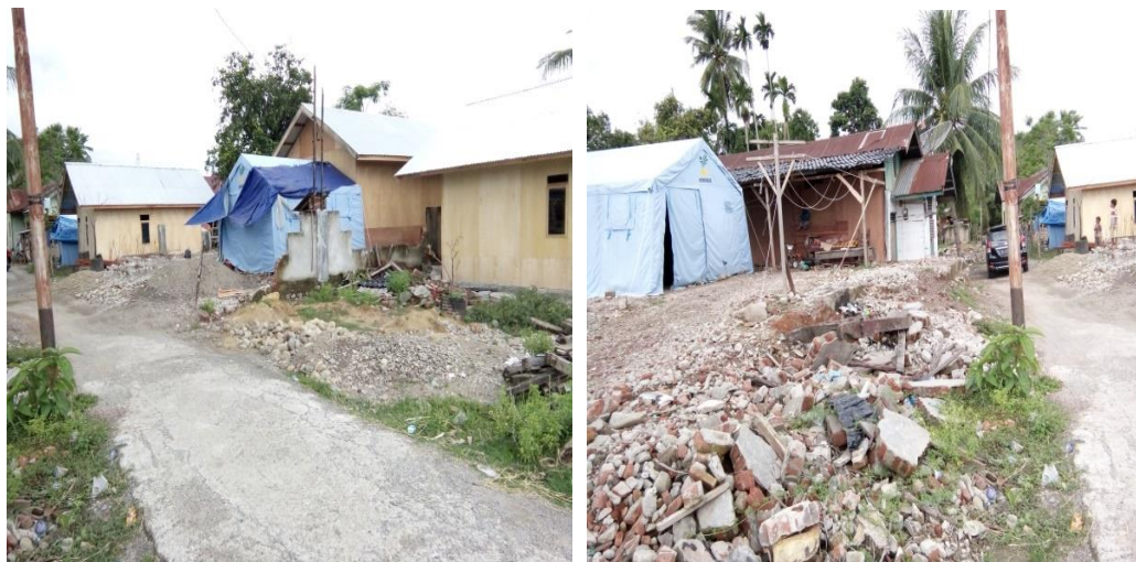
Gambar 8. Kondisi pasca gempa 7 Desember 2016, Kecamatan Trieng Gadeng, Pidie Jaya
