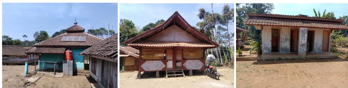
Gambar 3. Masjid, Bale Warga dan jamban umum di Kampung Cigumentong
